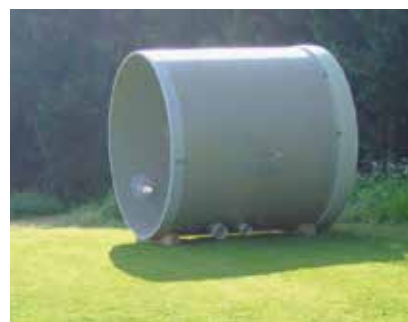
Obr. 2.8 | Skladování vodorovných šachet
